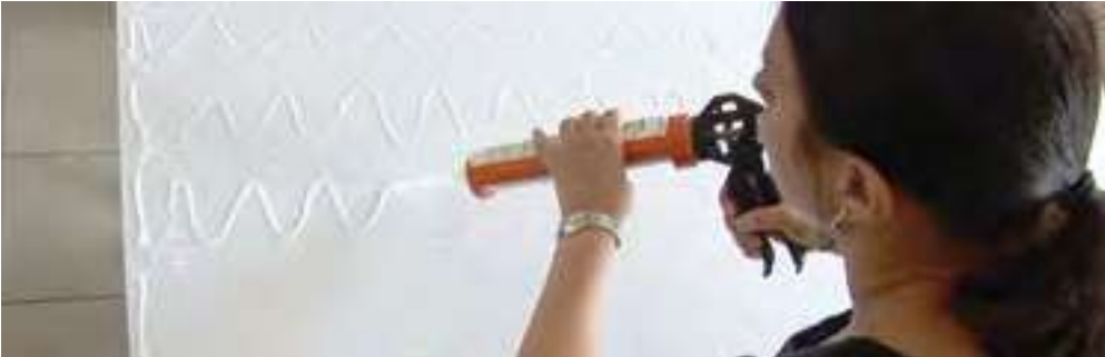
2. Encollage avec du silicone transparent sur l'arrière de votre panneau
