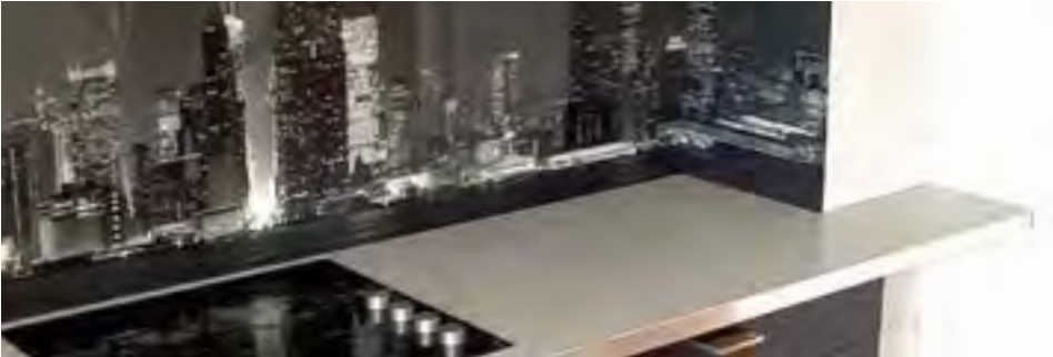
4. Application d'un joint de silicone transparent au ras du plan de travail pour assurer l'étanchéité au-dessus de l'image
