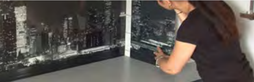
3. Pose de la crédence 2 en raccord parfait avec la crédence 1
