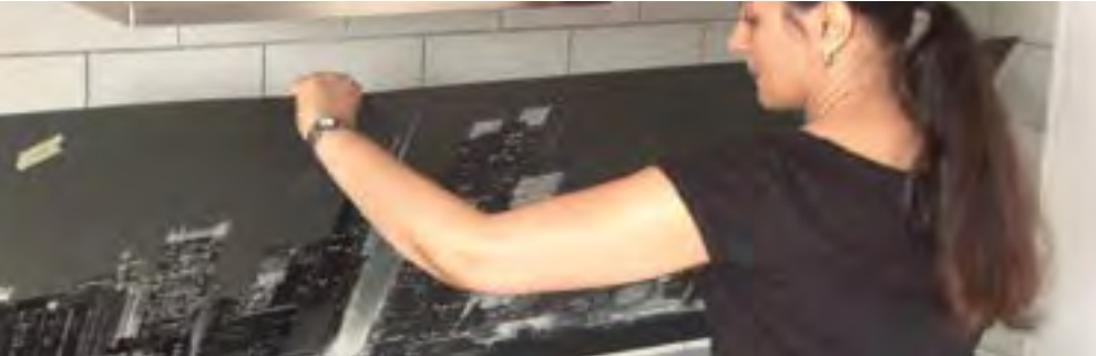
1. Présentation du ou des panneau(x) à blanc (sans colle) et vérification de la continuité du décor
